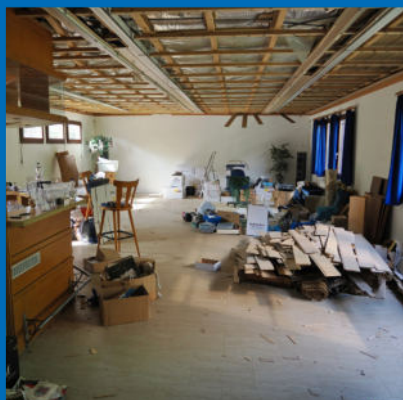
Abriss-Beginn im Klubhaus
