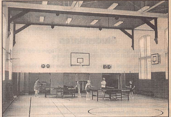
Unter Beibehaltung der historischen Vorgaben wurde die um die Jahrhundertwende gebaute Halle von Grund auf renoviert.
